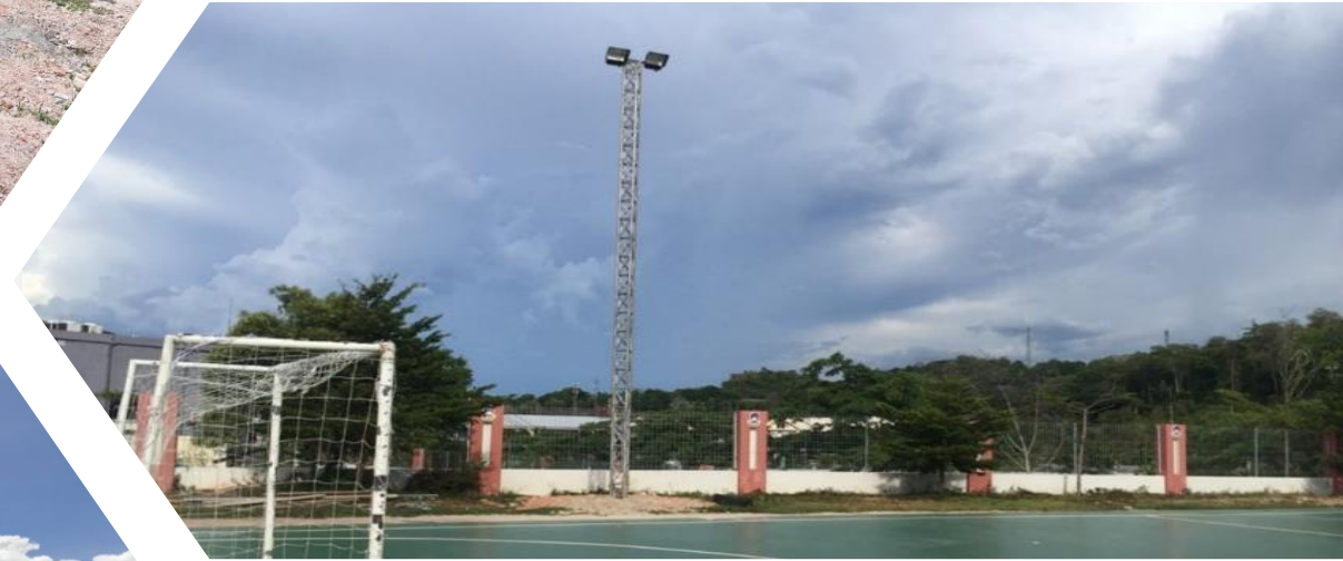
ซ่อมบำรุงติดตั้งเสาไฟฟ้าพร้อมไฟส่องสว่าง ขนาด 150 W สนามฟุตบอล
